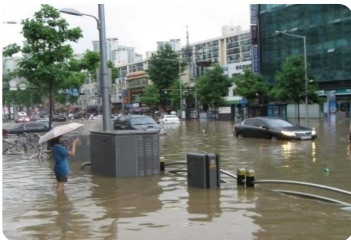
자연 재해로 인한 침수로 제어반 고장
