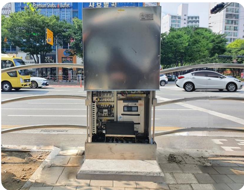
[ 자동 방수 제어반 설치 예시 ]
